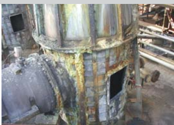
Fremdexposition der Säureschutzabbau-Monteurs bei Sanierungsarbeiten
