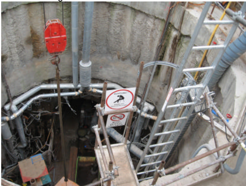
Bild 4: Abgang zum Stollen/Zuleitungsanlage Vereisung
