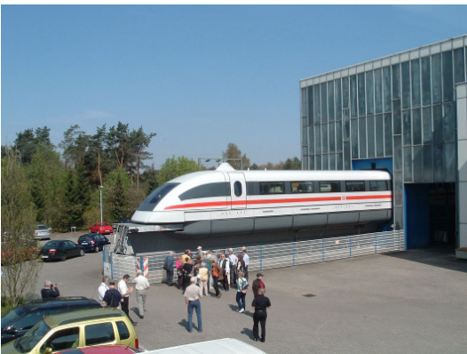
Abb. Transrapid Technikgebäude der Versuchsstrecke
