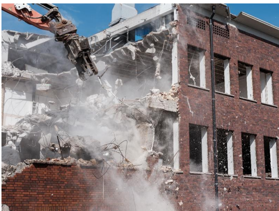
Abb. 16: Abriss des alten Gebäudes, Quelle: BASF SE
