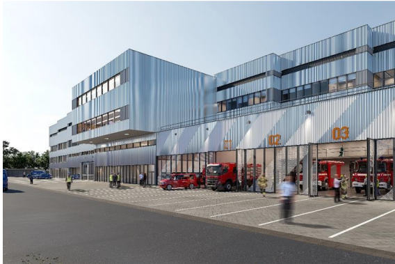
Abb. 15: Neues Gefahrenabwehrzentrum; Quelle: BASF SE
